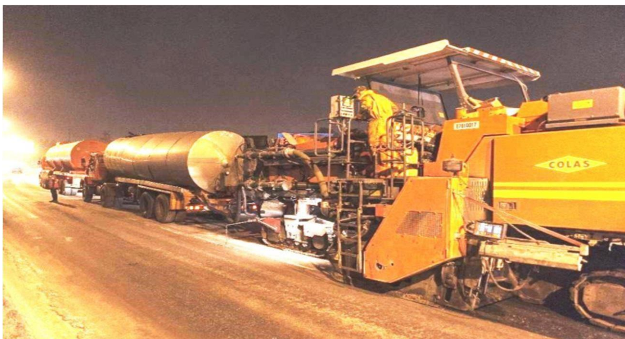
TRAVAUX DE RENFORCEMENT DE L'AXE BOUAKE - FERKESSEDOUGOU
