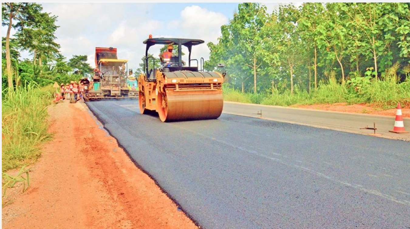
PROJET DE L'AUTOROUTE ABIDJAN-OUANGOLODOUGOU : SECTION YAMOISSOUKRO-BOUAKE
