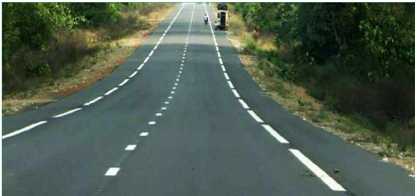
Dans le cadre de l'intégration sous-régionale, plusieurs projets sont en cours en Côte d'Ivoire dont la construction d'infrastructures routières.
